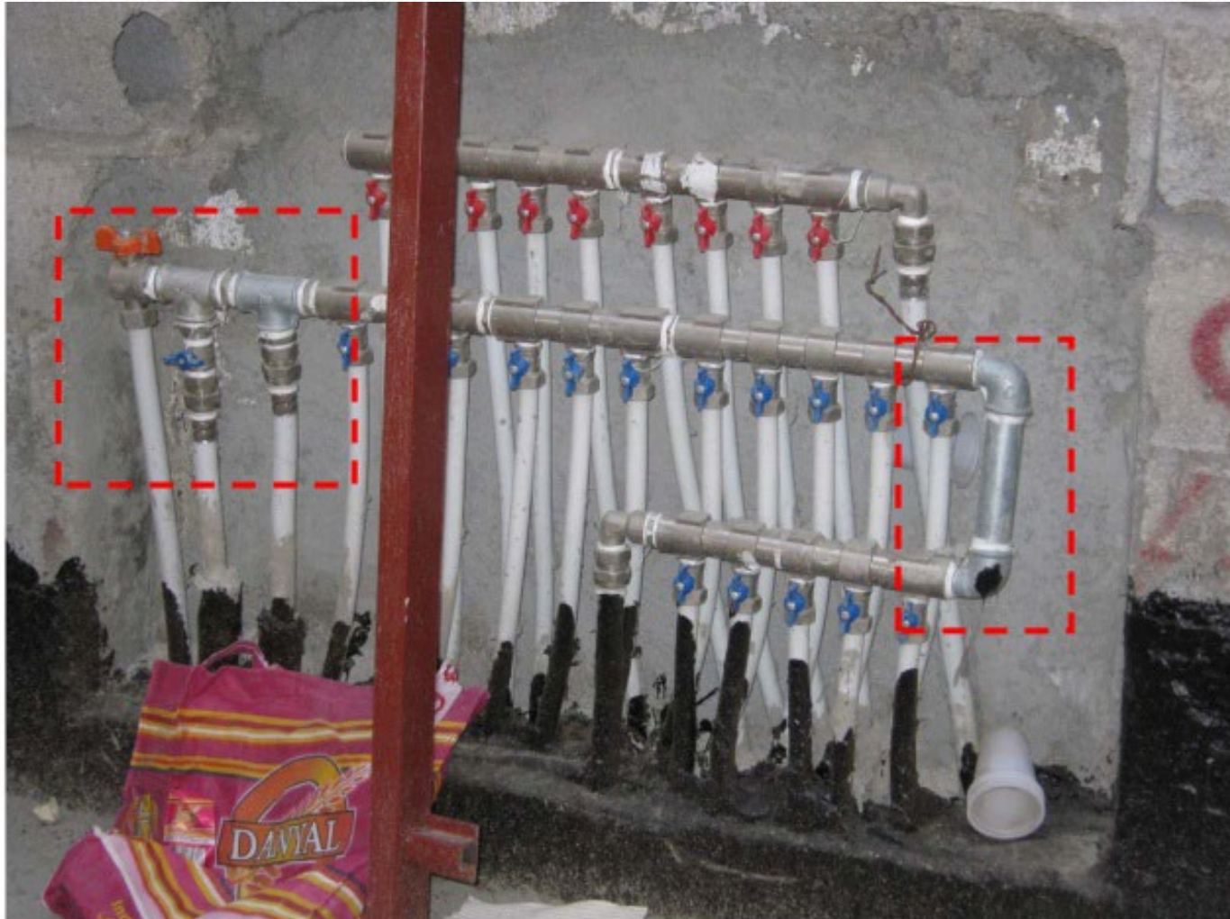
شکل ۱- استفاده از لوله و اتصالات غیر همجنس دکتر صدرواقفی/gescool.ir
