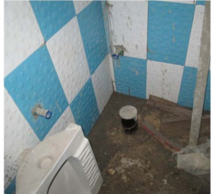
شکل ۲۲- عدم رعایت فاصله محور طولی از دیوارهای مجاور
