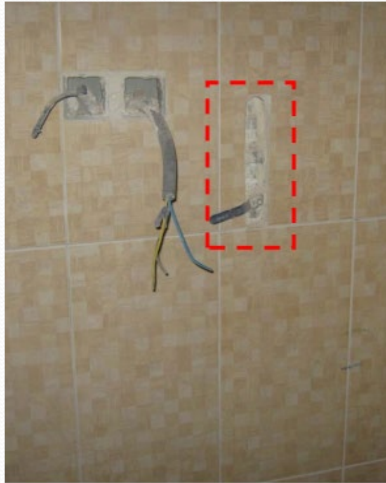
شکل ۵- مدفون شدن شیرآلات
