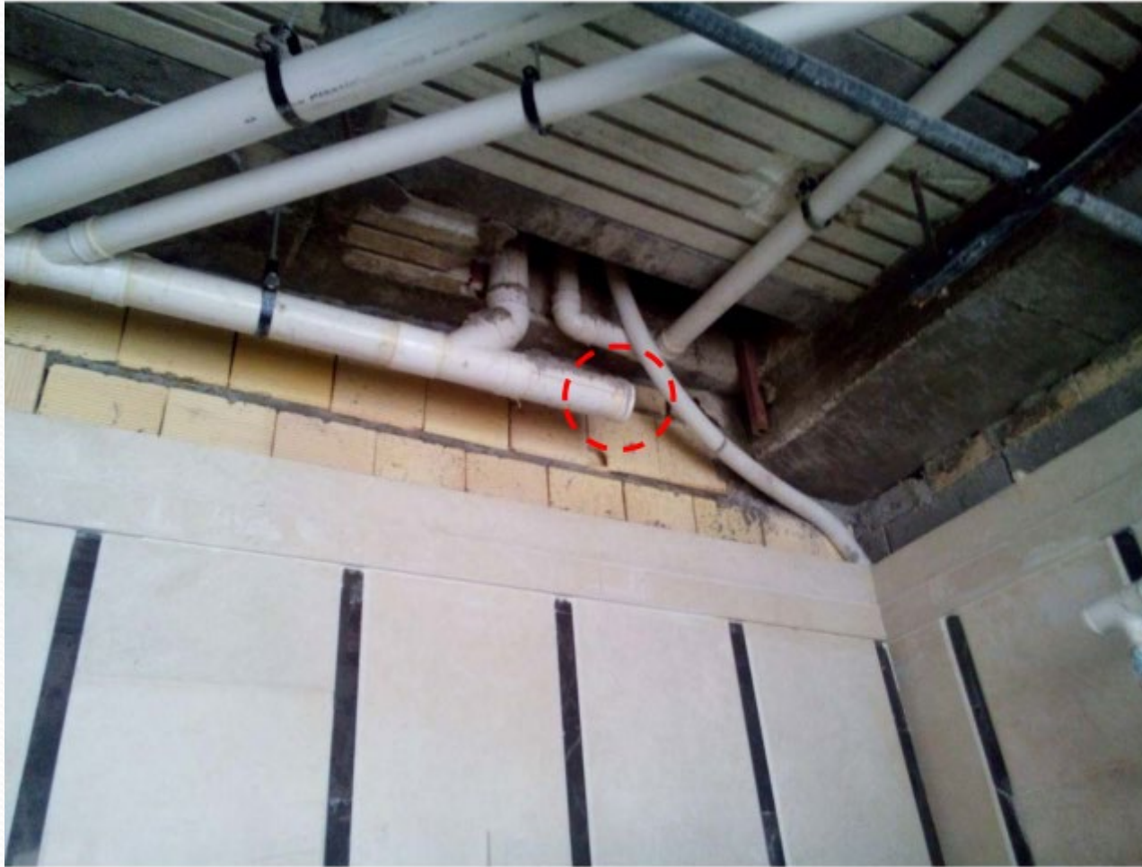
شکل ۱۷- استفاده از درپوش چسبی بجای دریچه بازدید
