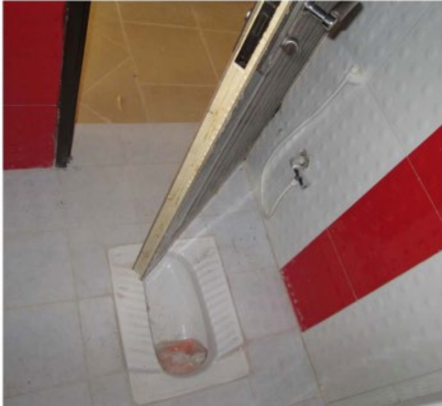
شکل ۲۳- محل نامناسب اجرای سرویس بهداشتی
