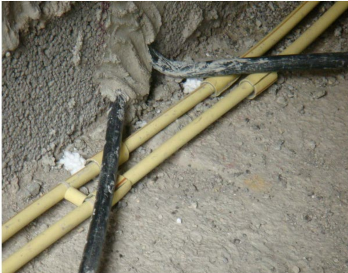
شکل ۲۴- اجرای غلاف مناسب غلاف گذاری بین لوله آب و برق
