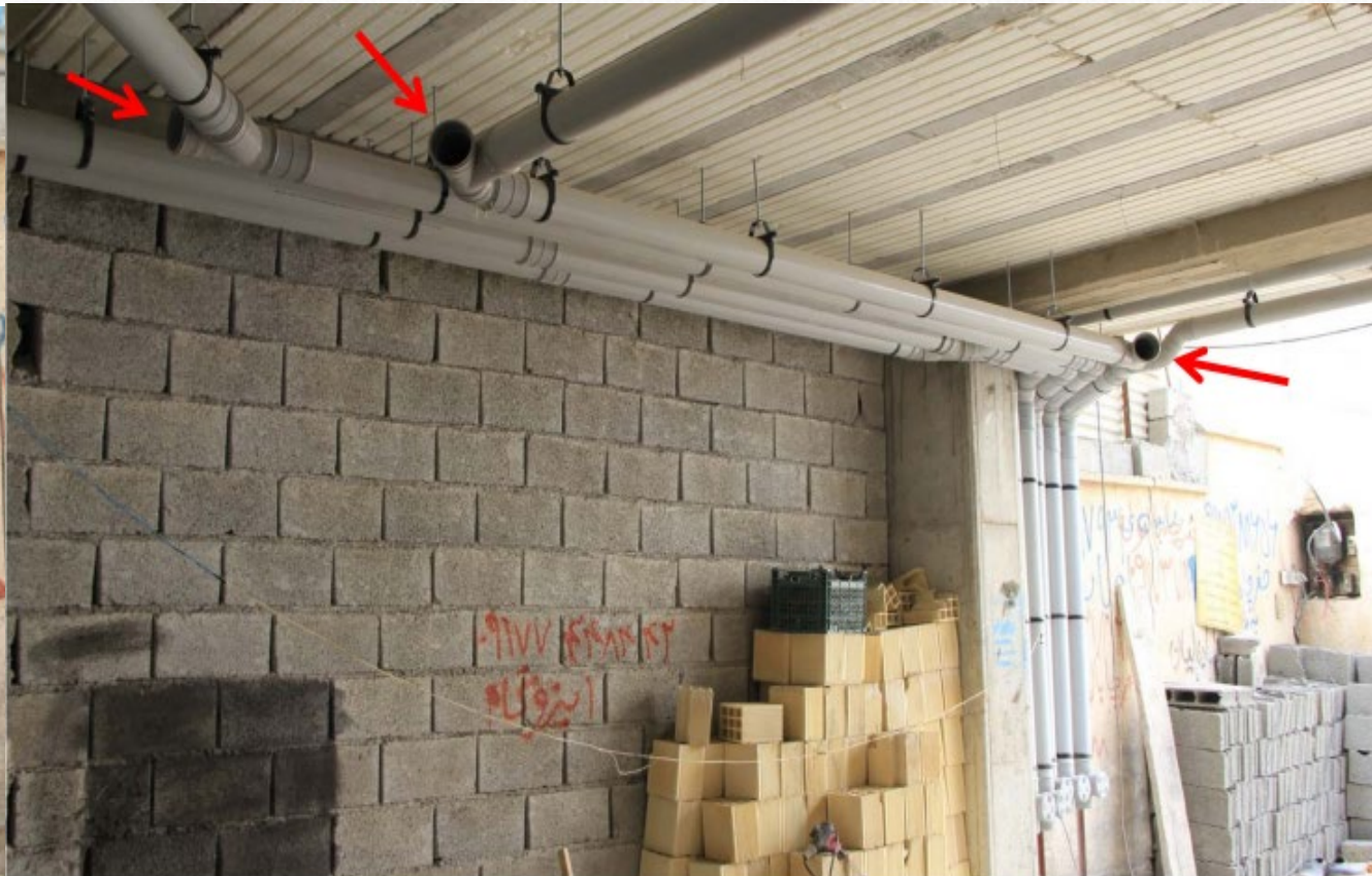
شکل ۲۱- اجرای صحیح دریچه بازدید
