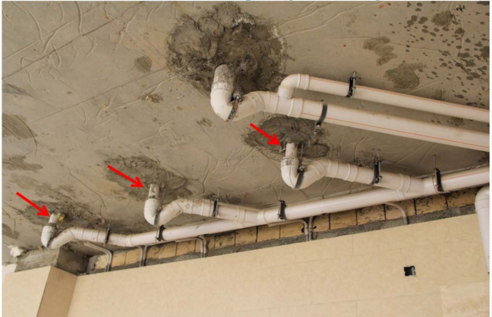
شکل ۲۸- اجرای نادرست از تبدیل ۲ به ۳ و عدم نصب دریچه بازدید در محل افقی خط
