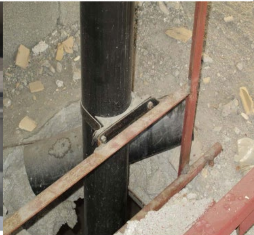
شکل ۷- اتصال مناسب بست به لوله
