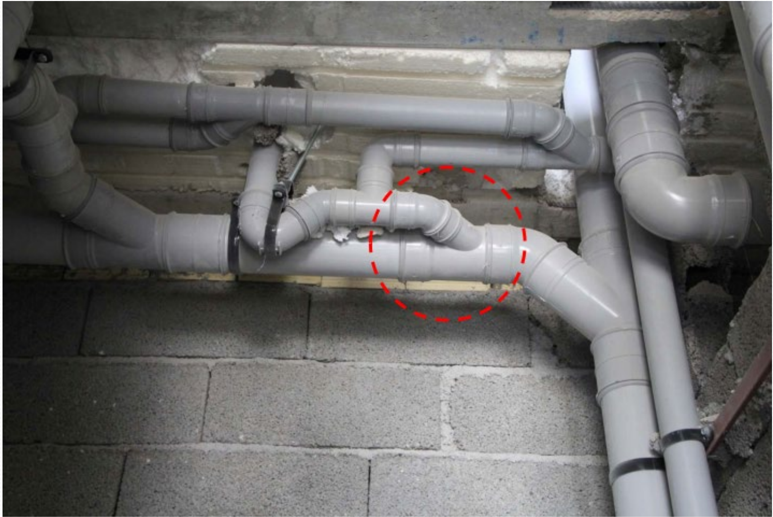
شکل ۲۹- استفاده صحیح از تبدیل
