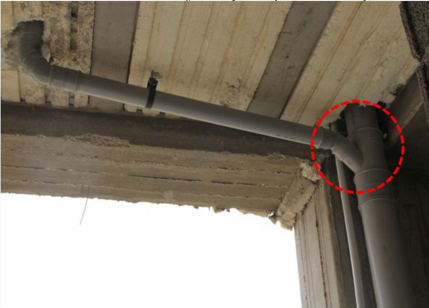
شکل ۳۲- استفاده صحیح از سه راهی تبدیل
