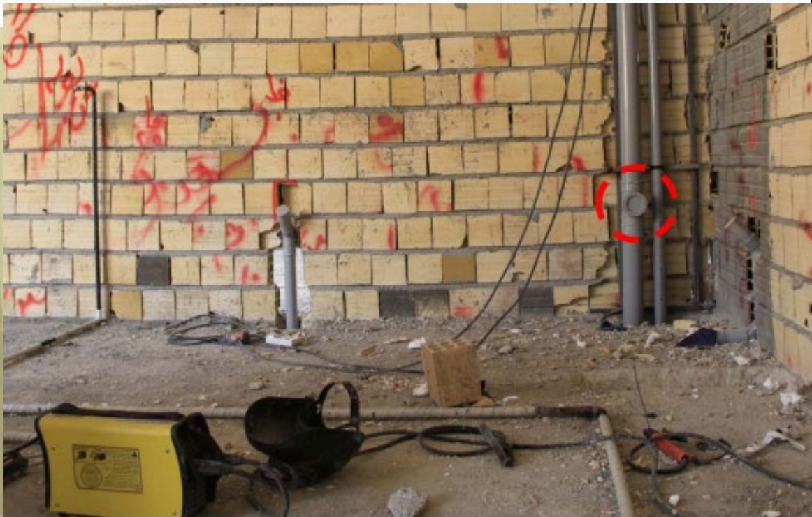
شکل ۱۹- اجرای دریچه بازدید در فضای آشپزخانه
