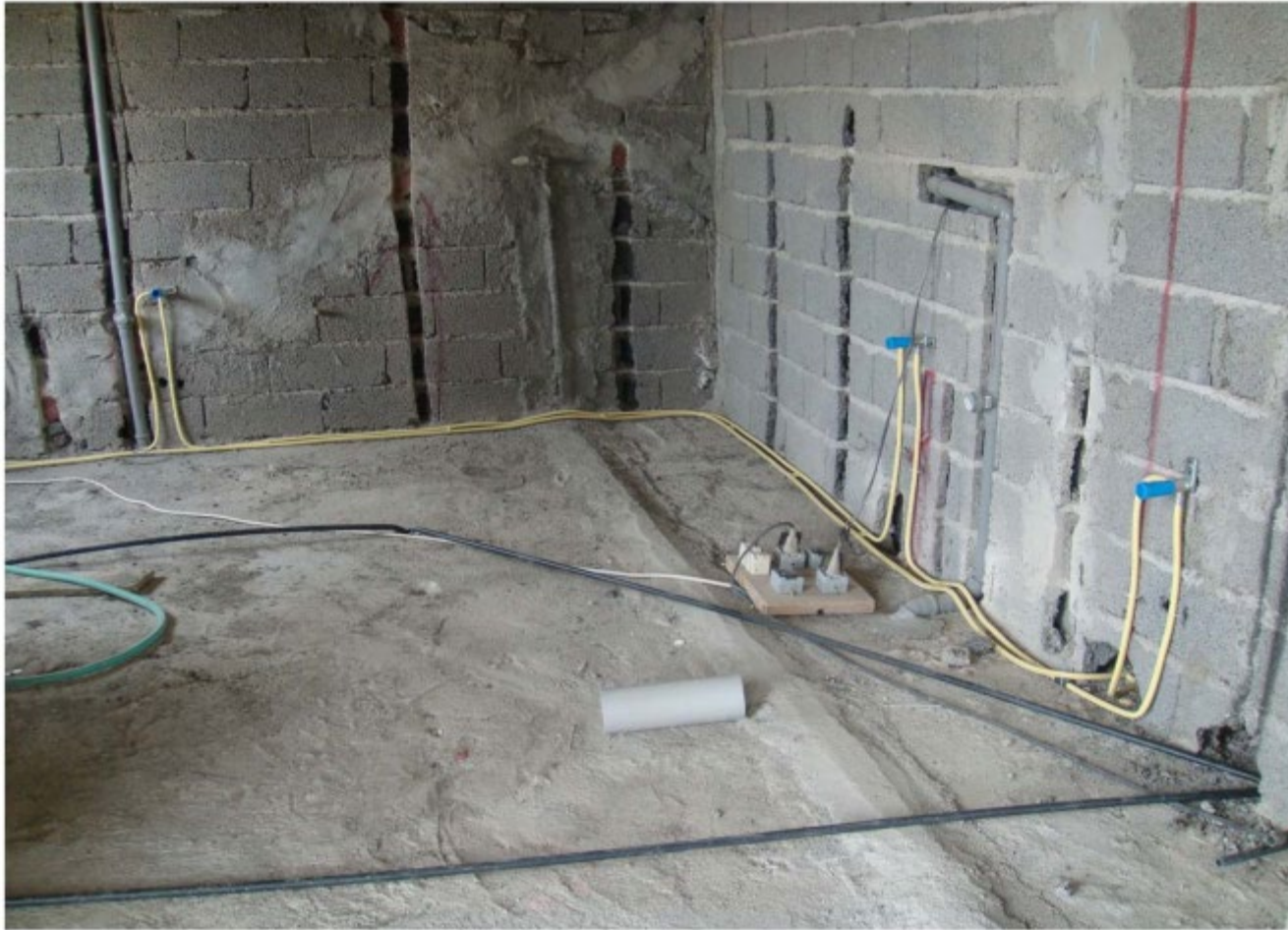
شکل ۶- بسترسازی مناسب جهت اجرای مطلوب لوله کشی
