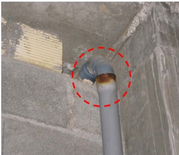
شکل ۱۳- سوختگی محل اتصال
