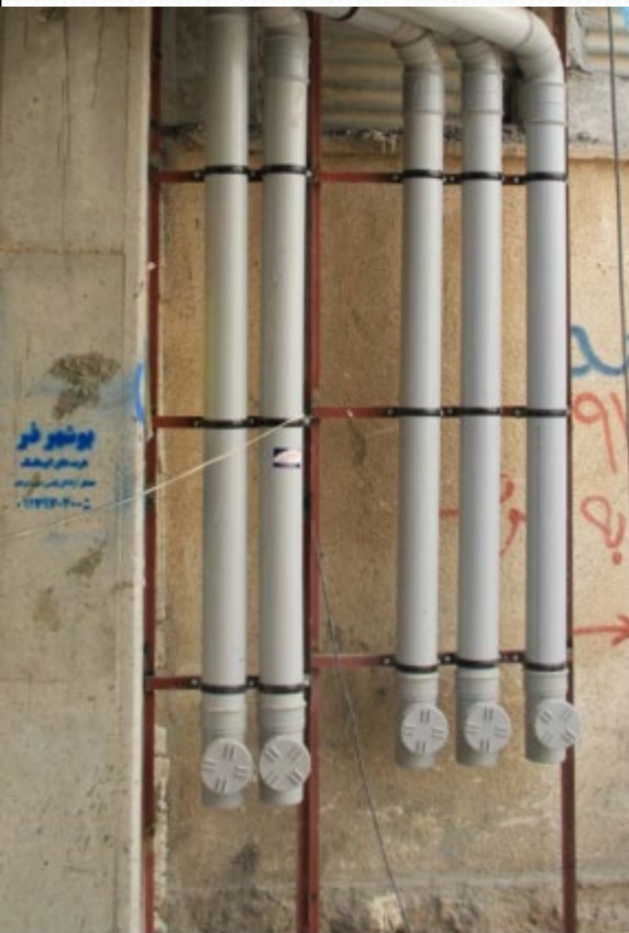
شکل ۲۰- اجرای صحیح دریچه بازدید
