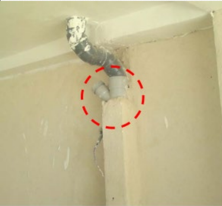
شکل ۱۸- محل نامناسب نصب دریچه بازدید
