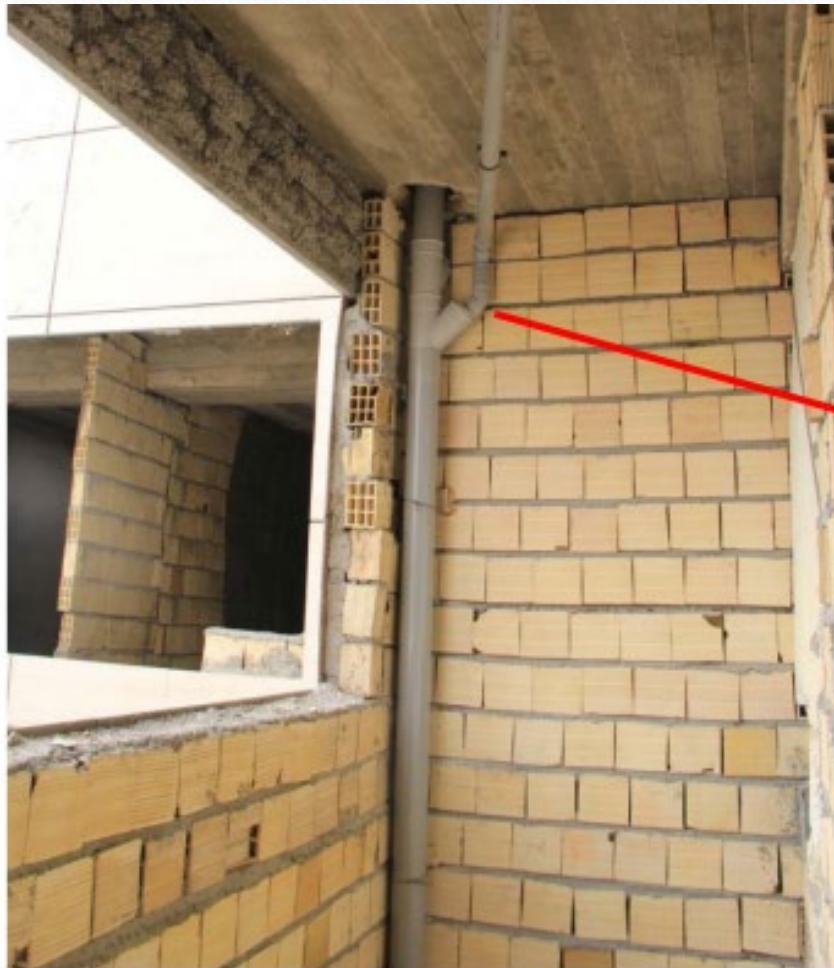
شکل ۳۱- استفاده از تبدیل نامناسب ۲ به ۵
