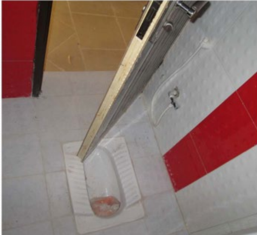
شکل ۲۳- محل نامناسب اجرای سرویس بهداشتی
