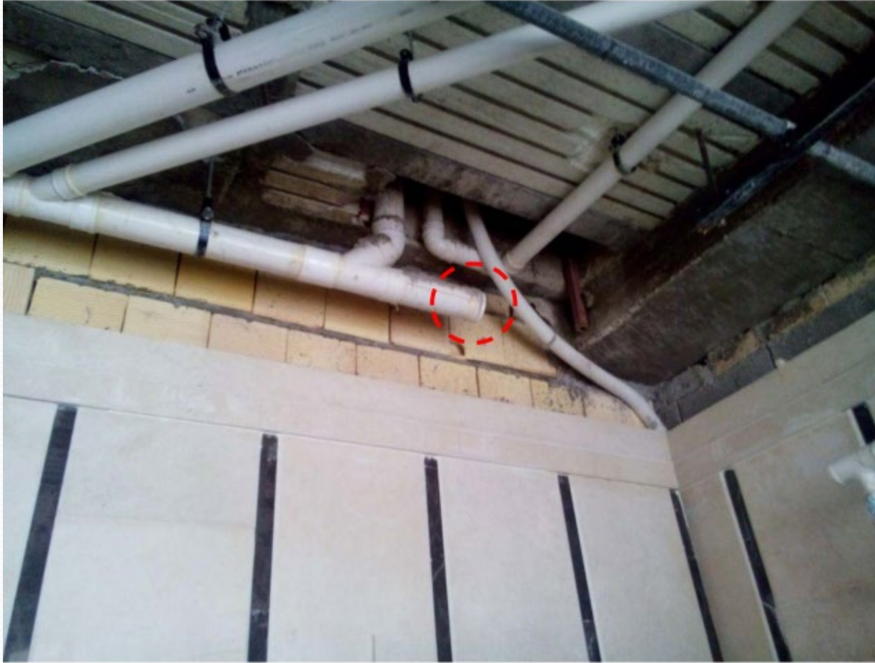
شکل ۱۷- استفاده از درپوش چسبی بجای دریچه بازدید
