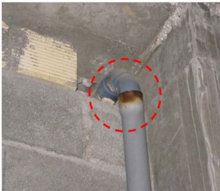
شکل ۱۳- سوختگی محل اتصال
