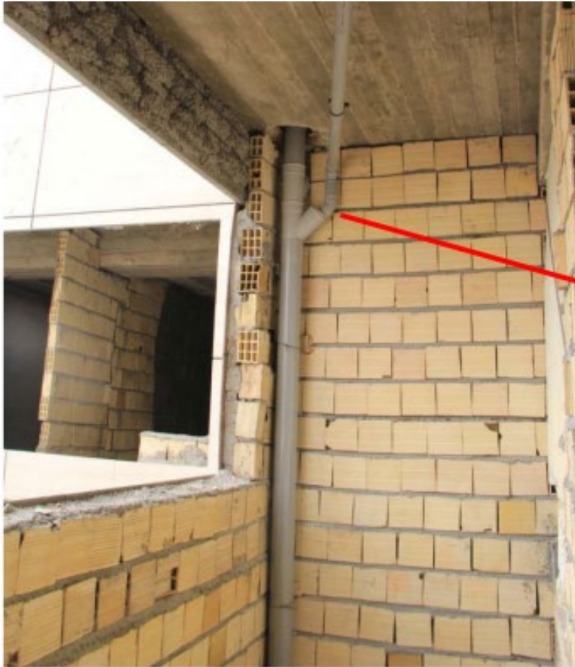
شکل ۳۱- استفاده از تبدیل نامناسب ۲ به ۵
