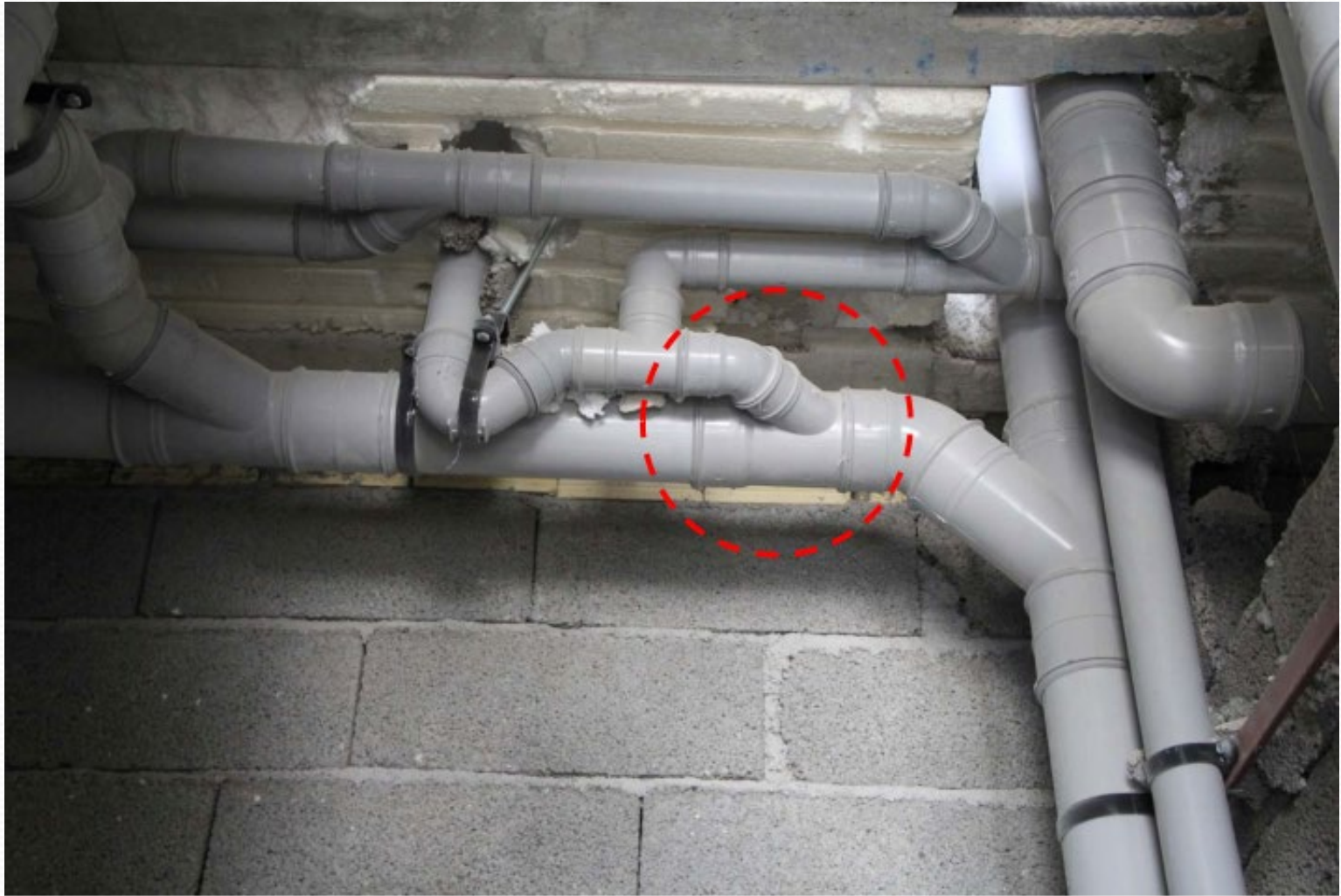
شکل ۲۹- استفاده صحیح از تبدیل
