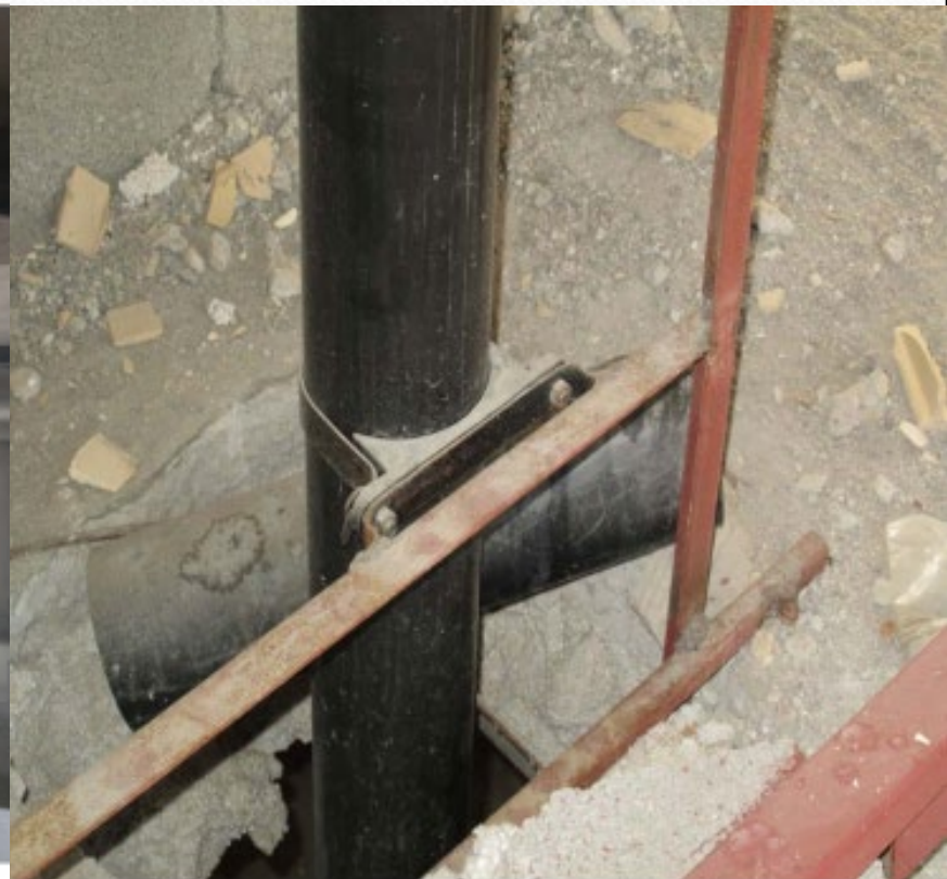
شکل ۷- اتصال مناسب بست به لوله
