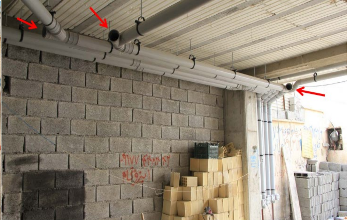
شکل ۲۱- اجرای صحیح دریچه بازدید
