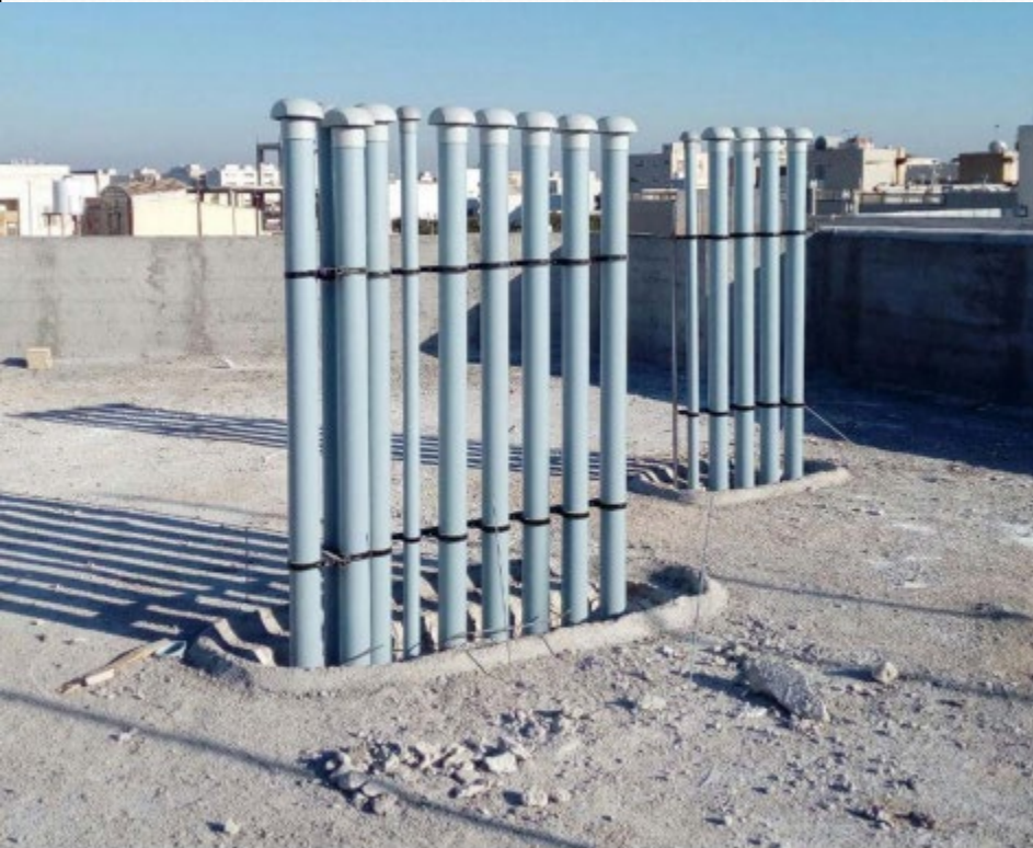
شکل ۳۹- نمونه کلاهک های مناسب جهت خطوط هواکش شکل ۳۸- استفاده از کلاهک مناسب بر روی رایزر هواکش در پشت بام
