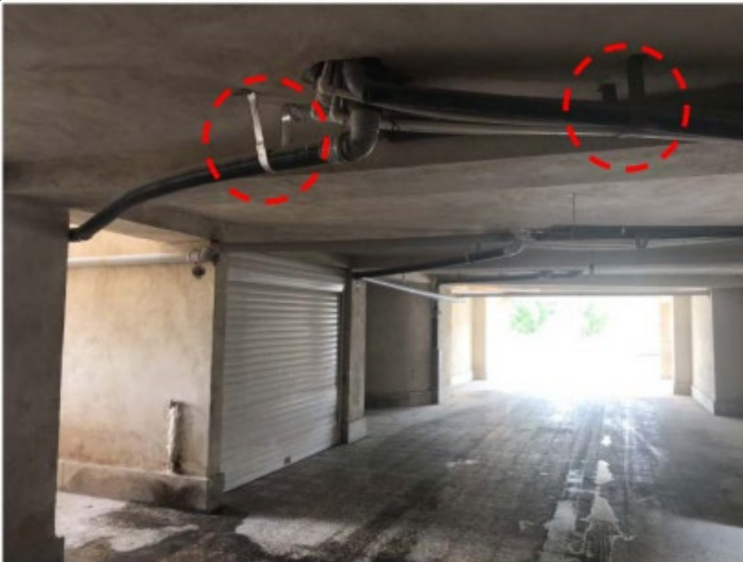
شکل ۸- استفاده از ساپورت های نامناسب در خطوط فاضلاب
