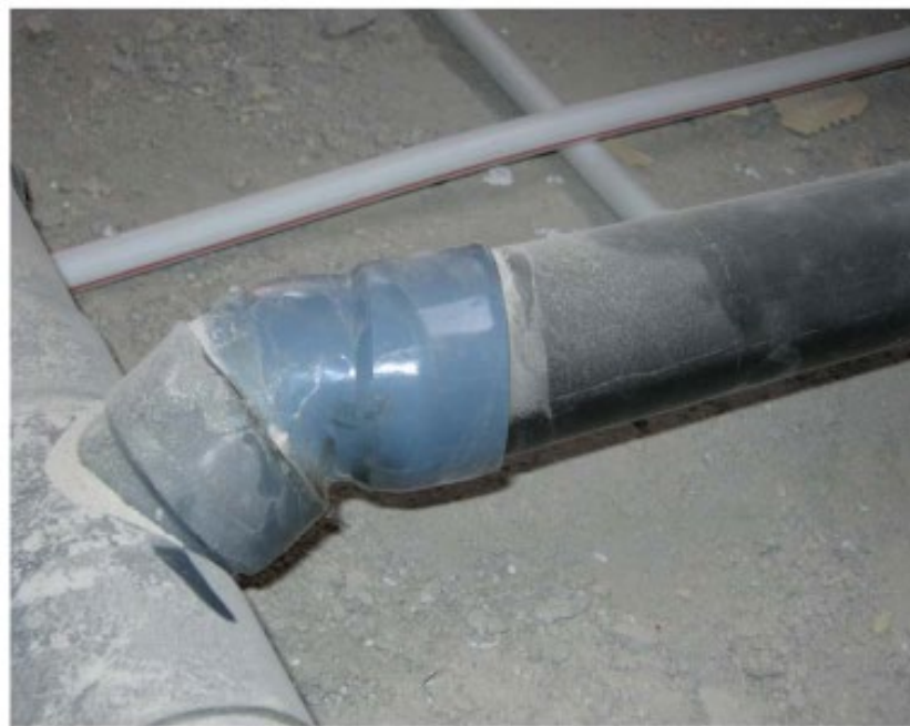
شکل ۱۲- گرم کردن نامناسب اتصالات
