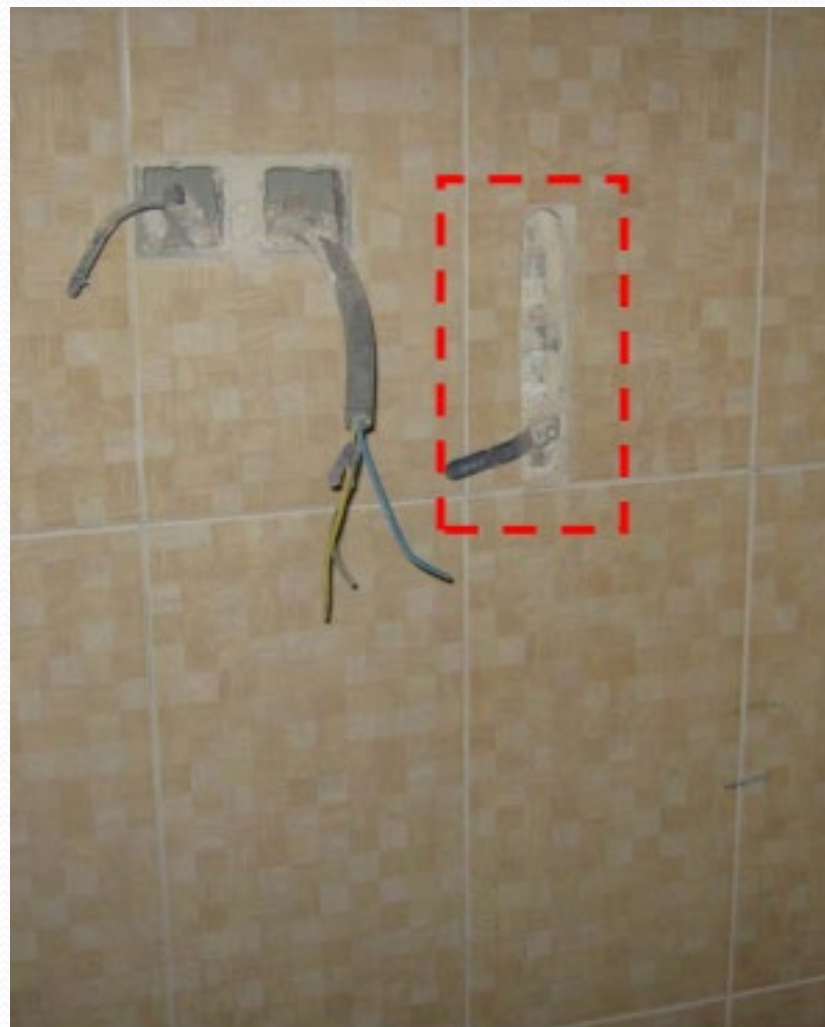
شکل ۵- مدفون شدن شیرآلات
