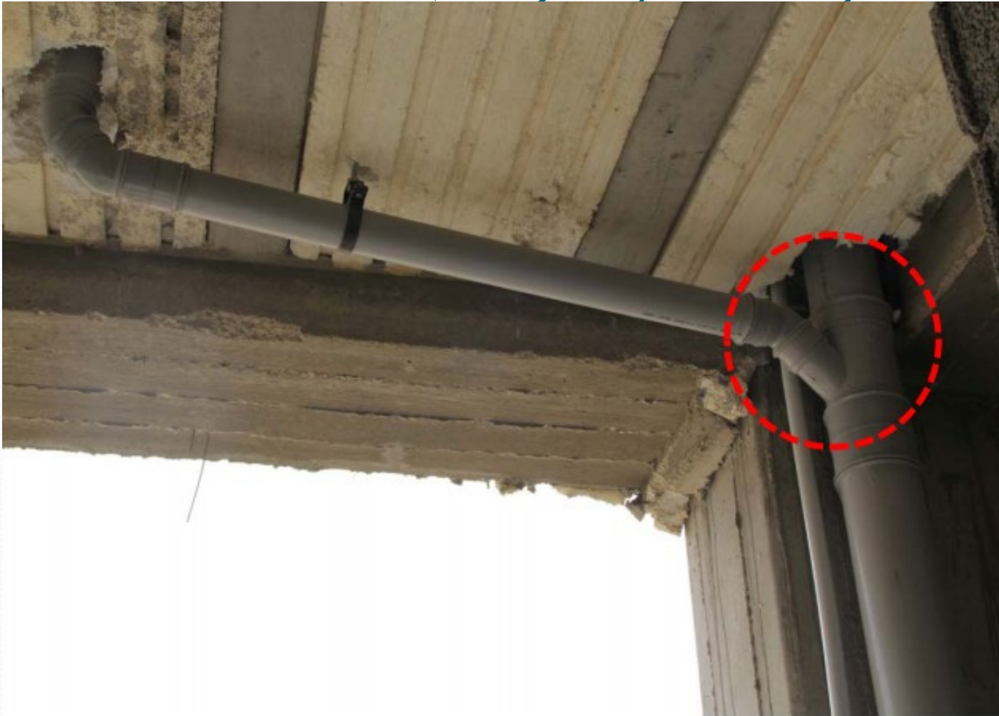
شکل ۳۲- استفاده صحیح از سه راهی تبدیل
