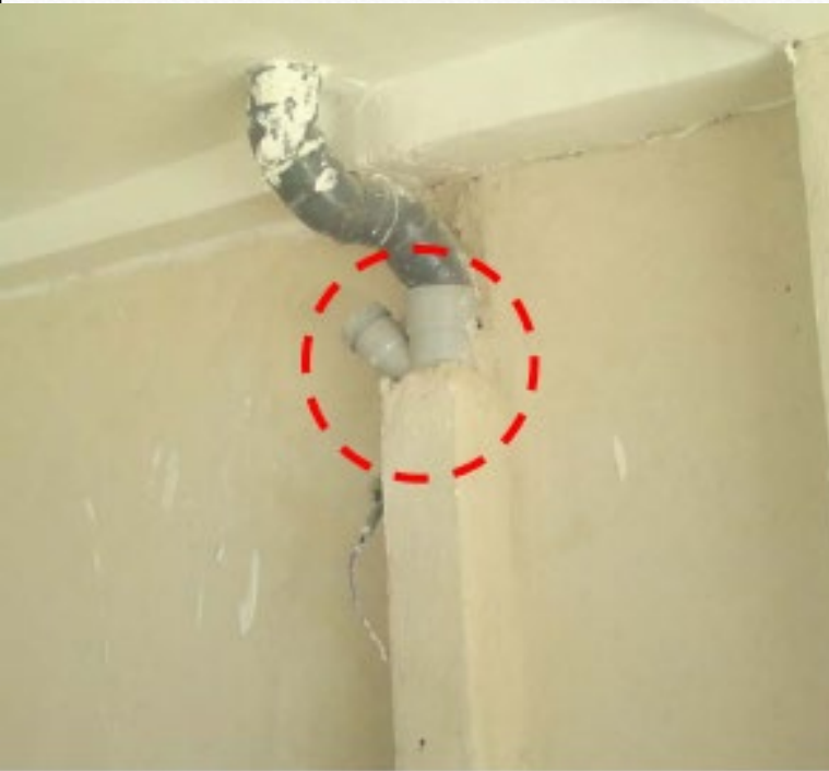
شکل ۱۸- محل نامناسب نصب دریچه بازدید
