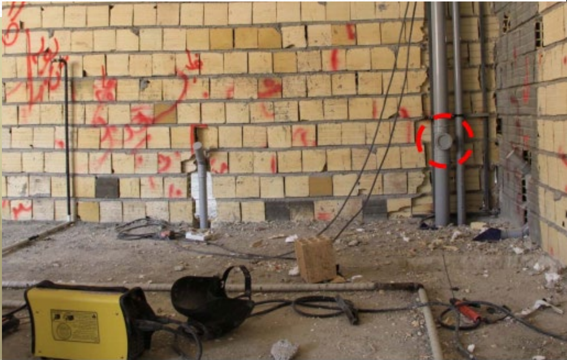
شکل ۱۹- اجرای دریچه بازدید در فضای آشپزخانه
