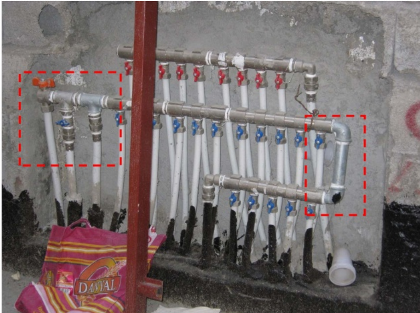
شکل ۱- استفاده از لوله و اتصالات غیر همجنس دکتر سید علی صدر واقفی
