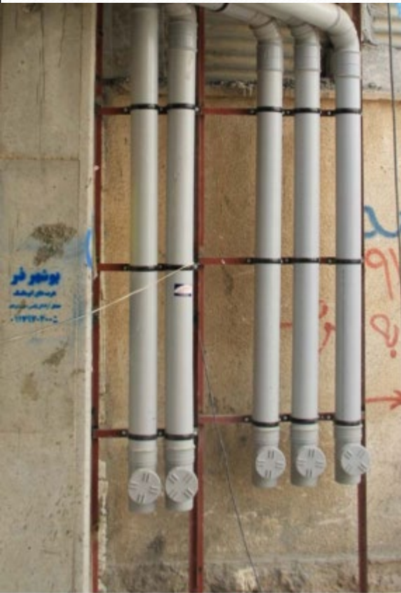
شکل ۲۰- اجرای صحیح دریچه بازدید
