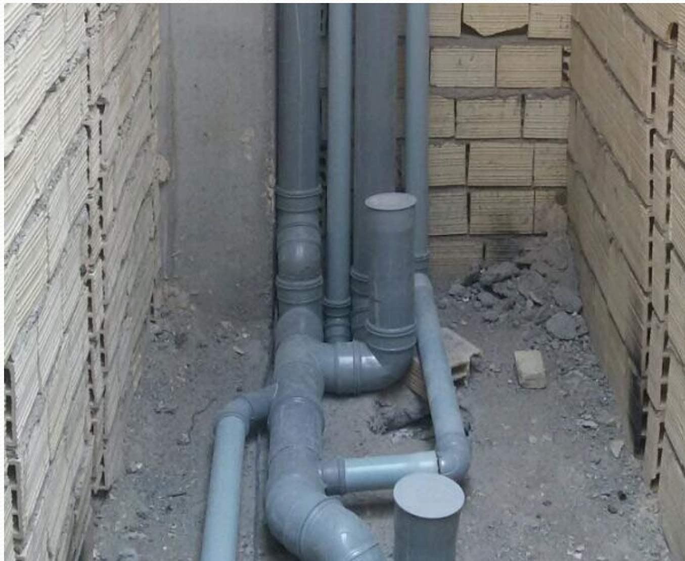
فاضلاب: لوله کشی روی کف
